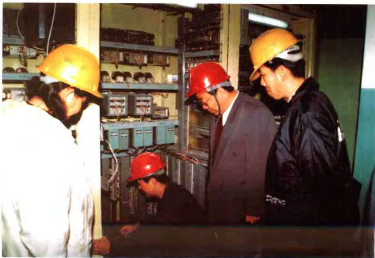
所领导深入调试现场
