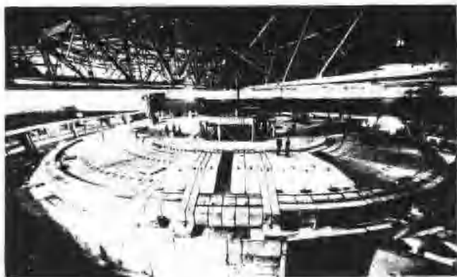
圖為在柏克萊的加利福尼亞大學勞倫斯輻射線實驗室中的貝他加速器，在擴建後的情形，它是用水泥屏蔽罩起來的。
