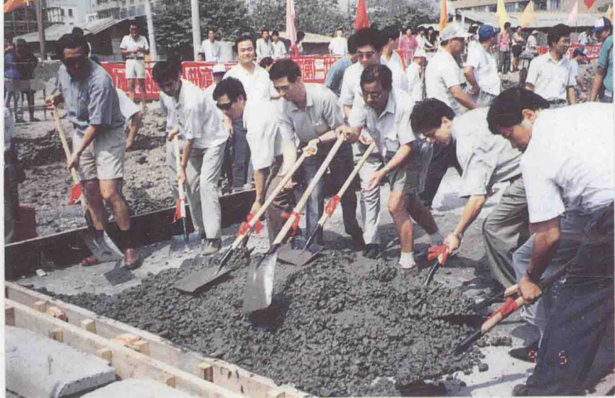
源深路改建工程浇捣第一块混凝土路面
