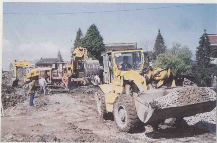
正在紧张施工的同高路建设工地
