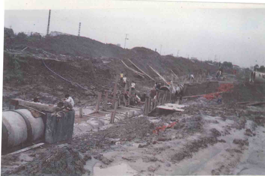
同高路工地正在进行排管施工
