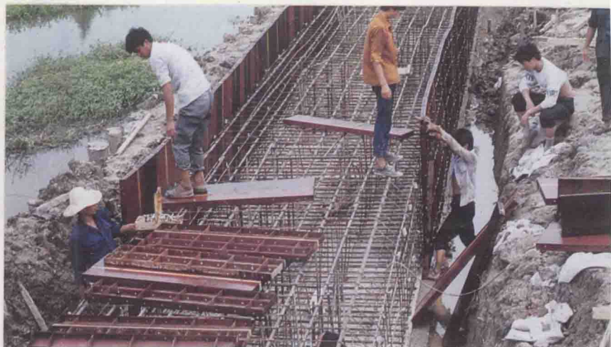
龙东路建设工地
