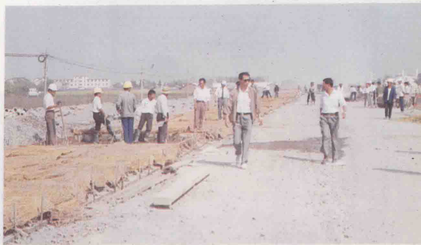
龙东路工程建设工地
