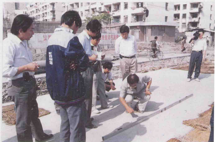
混凝土路面质量验收
