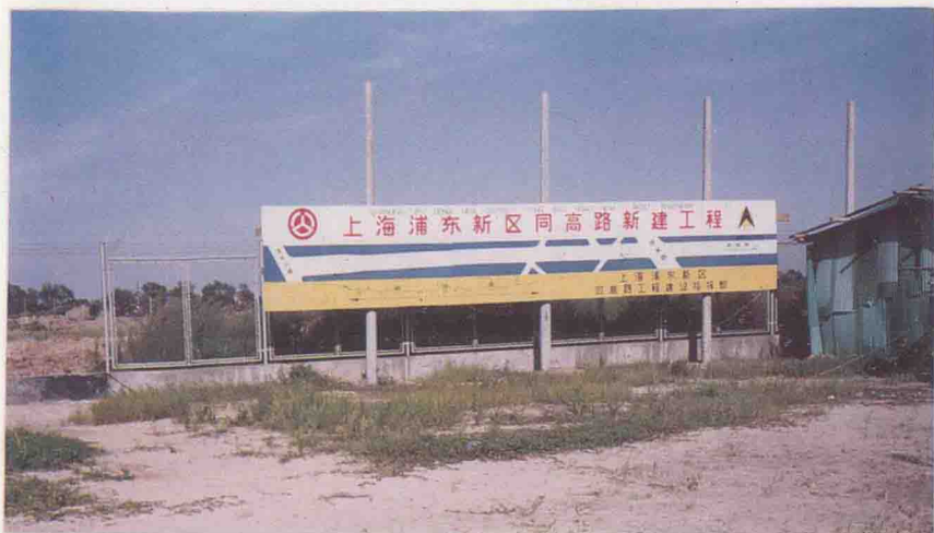
同高路工地现场
