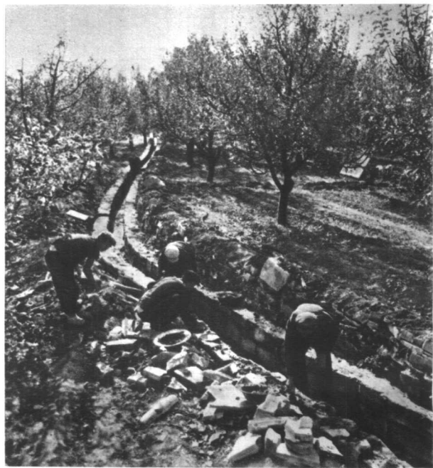
铺砌渠道， 引水上山。
