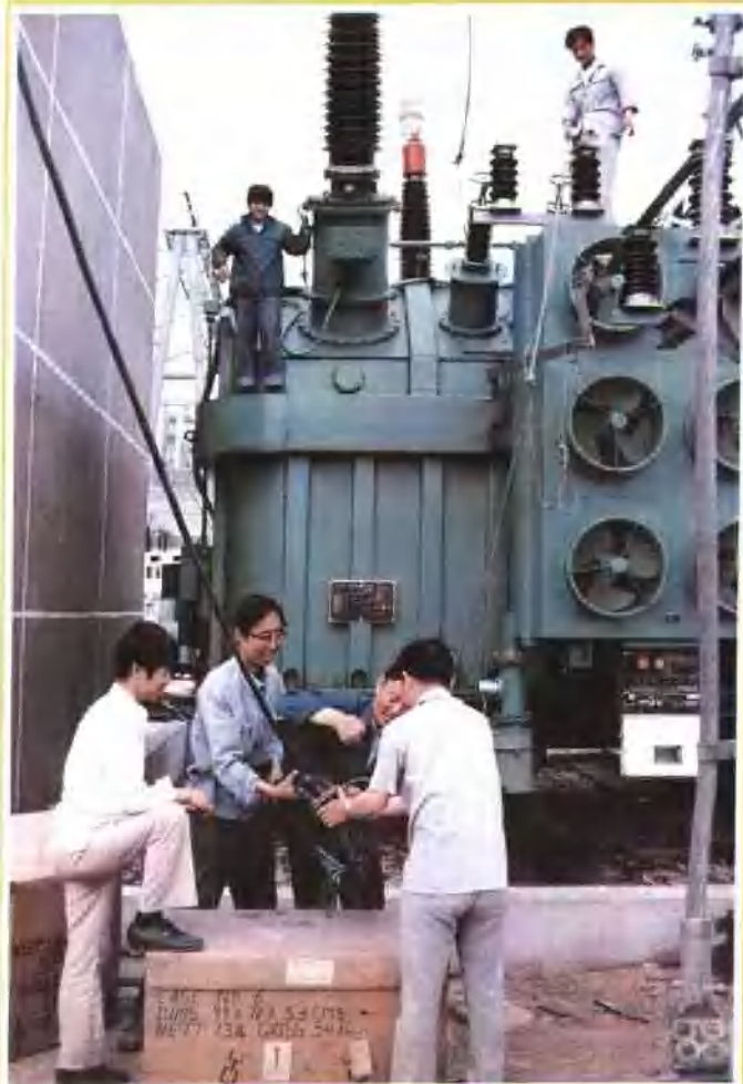
进行变压器试验
