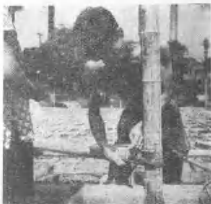
(6) 在竹管的衔接地方加用 14 号铅丝分段包扎五、六圈,使其更为牢固。再用铅在上下焊牢,使铅丝不至松散。
