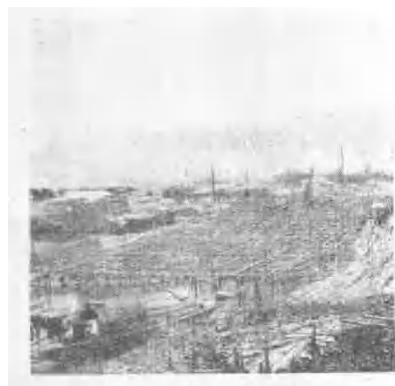
(1) 在游泳池江边斜坡处搭制斜形竹架(便于滑行),以便游泳池在江面制造完成后,于潮水最高时把它抬入江中。
