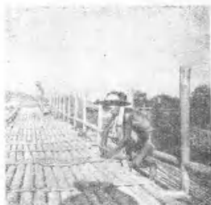
(12) 在浮力竹排上加置竹壓架，使它不易鬆動或浮起來。
