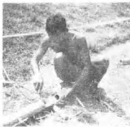
(4) 按照本图的制造方法(將竹管凿成弧形并經火燒)可使竹管互相銜接地方特別結实牢固。
