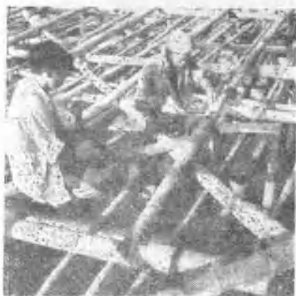
(8) 主要的衔接地方用 26 号或 28 号白铁片包在铅丝外面焊固,以防铅丝松散,非主要衔接地方只要用铅焊在铅丝上下,即使有个别铅丝断了,亦不致全部松散。
