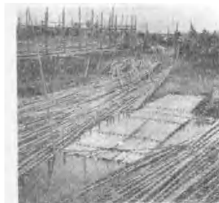
(3) 將竹去皮后制成浮竹排,裝在游泳池四周走廊底,可以控制水的浮力。
