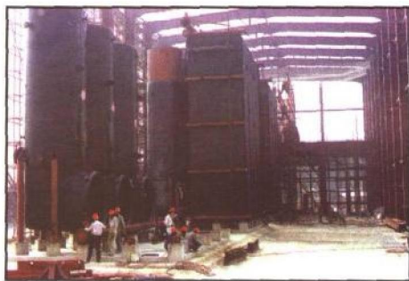
北京巴·威公司与芬兰公司合作生产的116MW燃气热水炉双榆树供热厂安装现场
