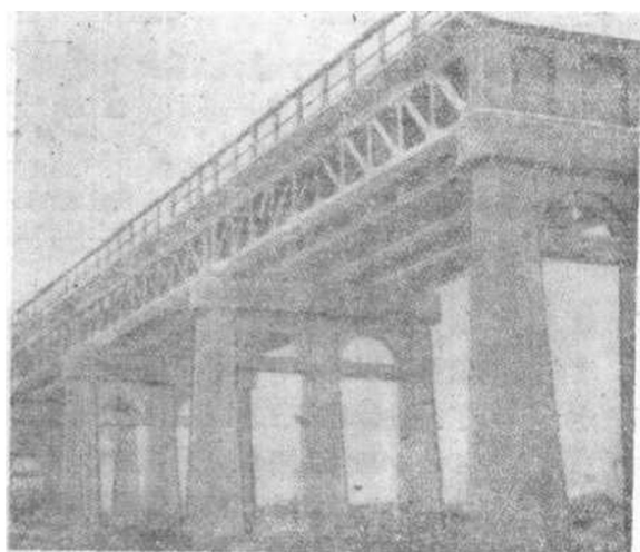
圖3 格式桁梁組成的上部構造
