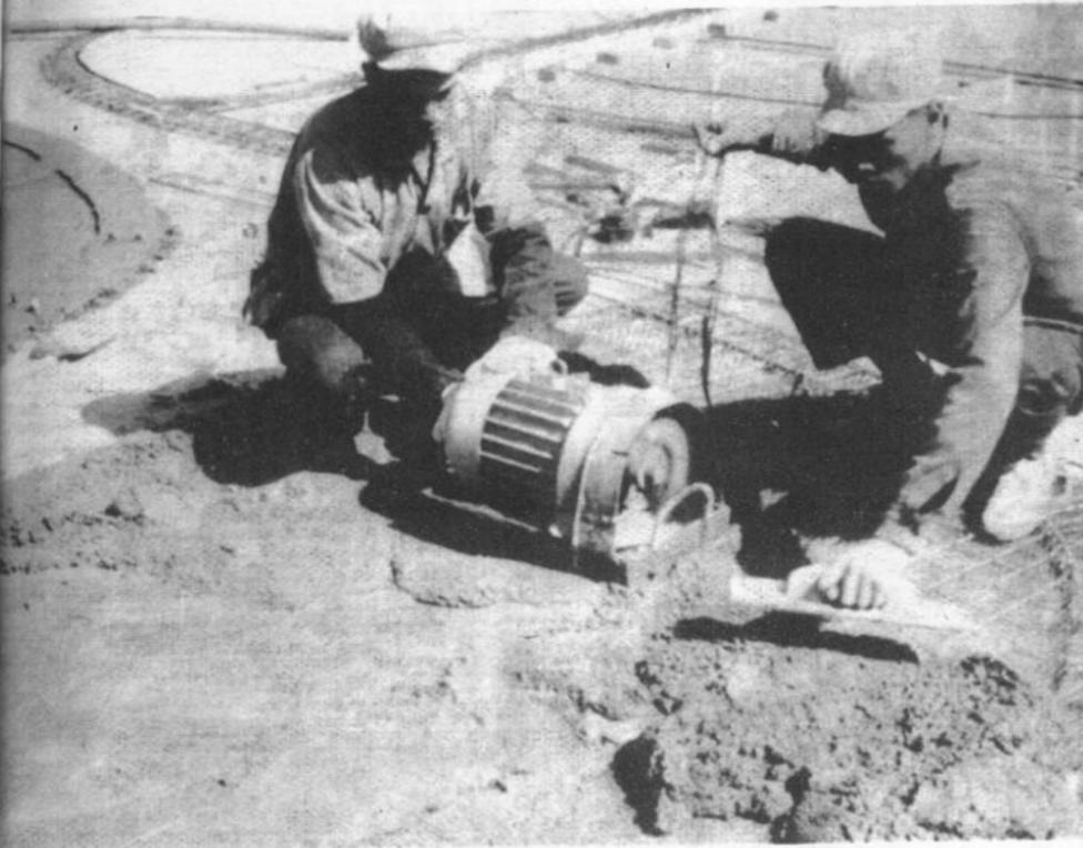
11. 水泥船也和陆地上的水泥建筑构件一样，最怕内部有空洞、“蜂窝”。所以，在抹水泥沙浆时，要压实抹平，不让里面留有气泡或空隙，以免形成“蜂窝”、麻面影响质量。在涂抹沙浆时，用震动器将沙浆震实，这对提高质量效果很好。
