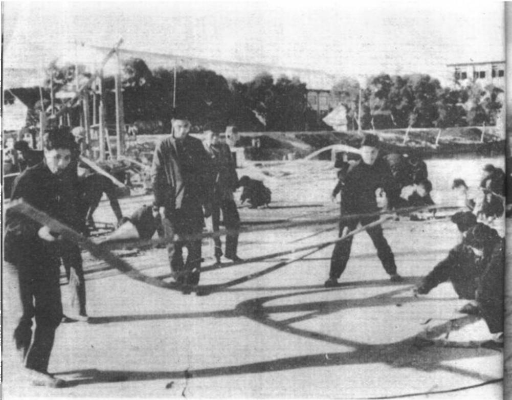
8. 有了“大样”，不仅可以制作木模，还可以按照“大样”的尺寸、形状弯制钢筋，做成水泥船某些构件的钢筋“骨架”。
