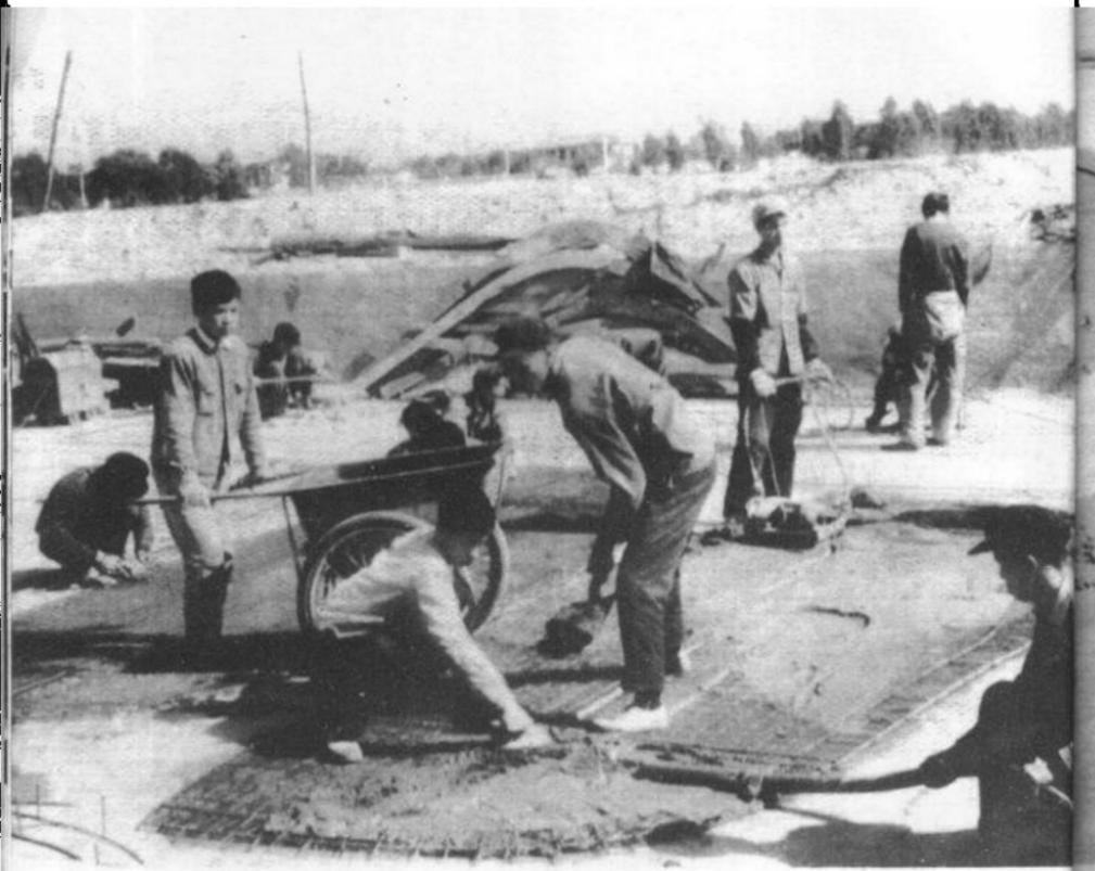
10. 水泥船有了“骨头”还需要有“肉”。水泥沙浆就是它的“肉”。只有“骨头”没有“肉”是不行的。“骨架”做好后，下一步就是在“骨架”两面涂抹水泥沙浆。水泥沙浆一般是用水、黄沙和水泥按一定比例搅拌成的。
