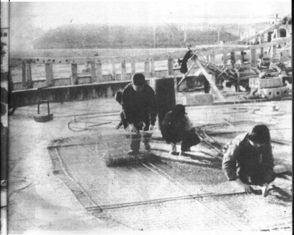
9. 有了钢筋骨架以后，再在钢筋骨架两面铺扎钢筋和钢丝网。根据船的大小不同，可铺二至四层钢丝网，中间夹一层钢筋。例如水泥船的肋骨、隔舱壁等构件都需要预先扎制这种“骨架”。
