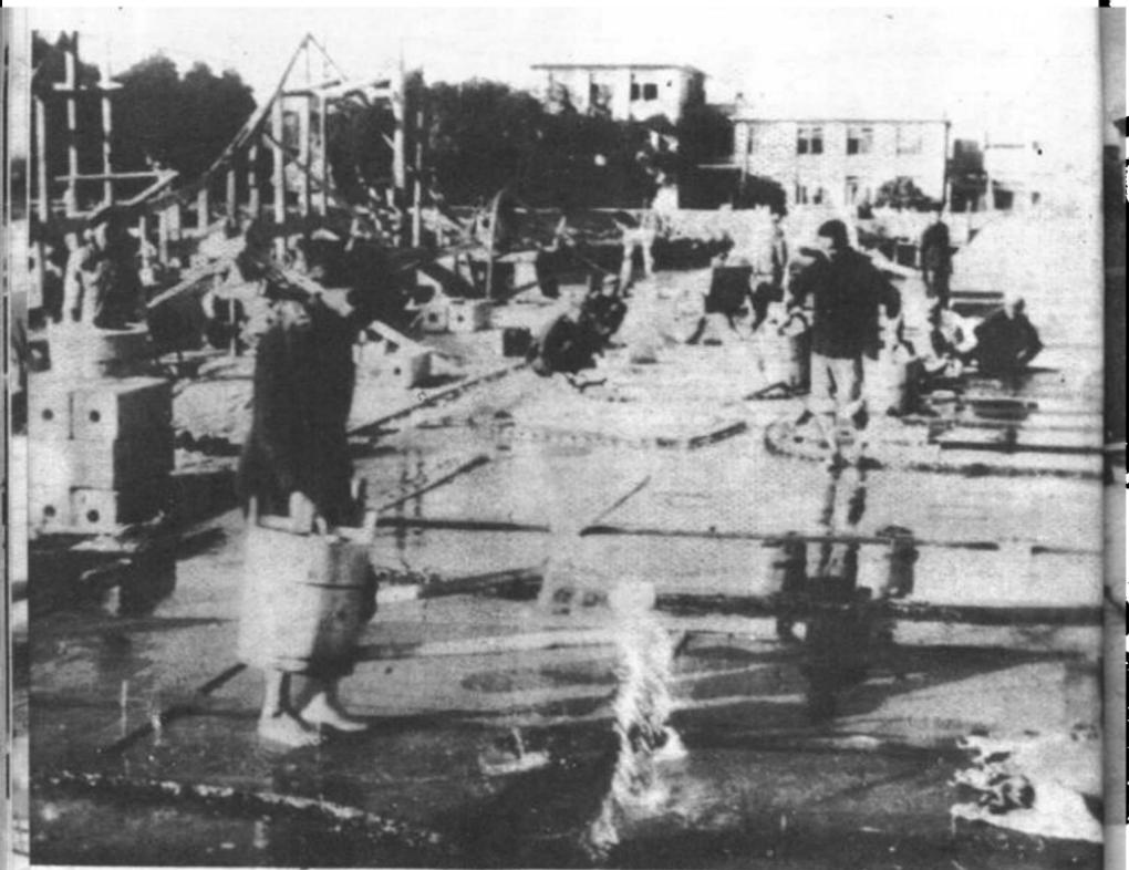
12. 为了保证水泥吸收充分的水分，形成牢固的结晶粒子，坚硬不裂，在水泥沙浆抹好后，还必须经过七天左右的洒水养护。在养护期间，不许暴晒或移动。养护不当，容易产生龟裂、断裂，都直接影响船的质量。
