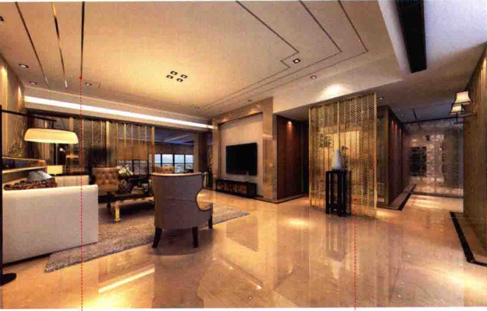
石膏板吊顶嵌不锈钢装饰条
