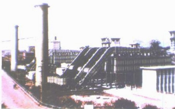
霍煤集团煤、电、铝产业链接(铝厂)
