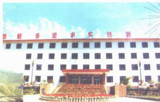
矿机关办公楼
