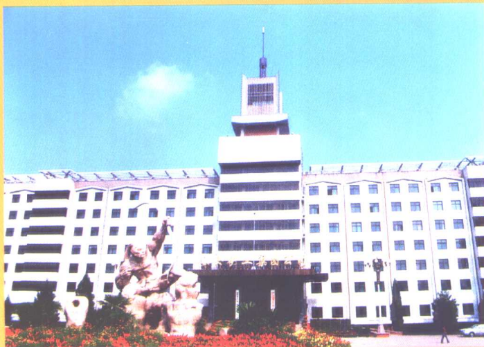
潞安矿业集团公司总部办公楼
