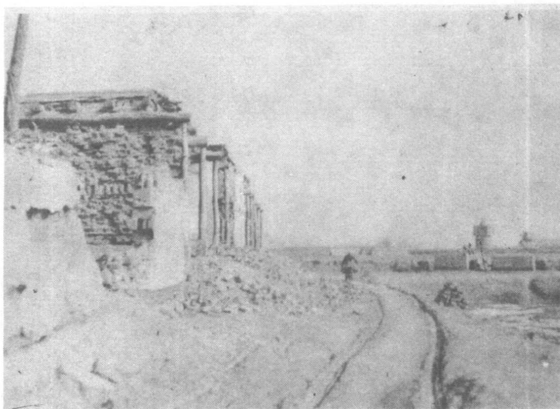
日寇破坏后的房屋
