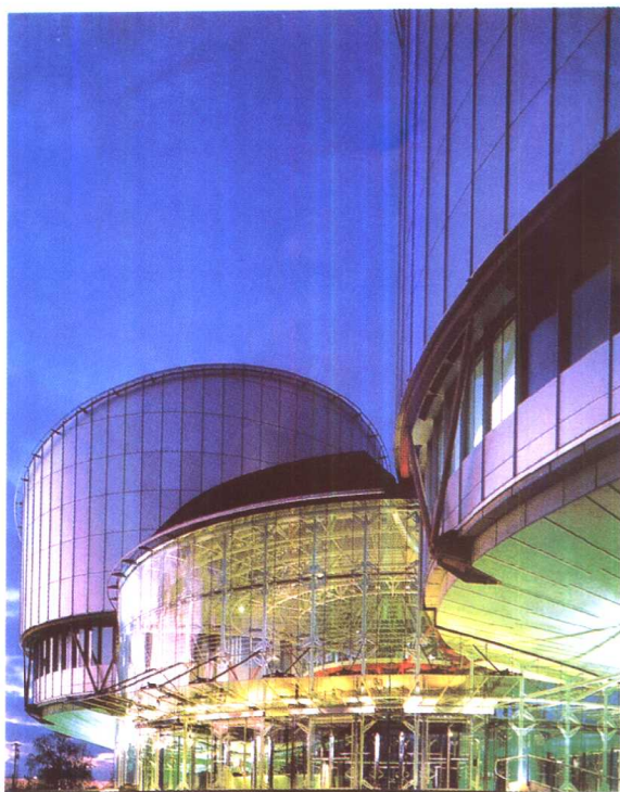
2.27 圆柱面半隐框幕墙
