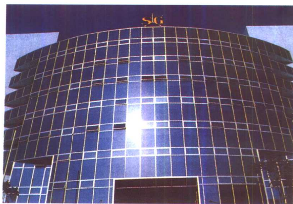
1.13 全虚墙面，宝石蓝玻璃明框幕墙
