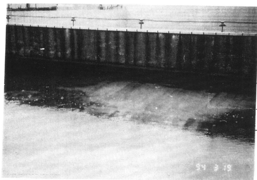
省立台北醫院屋頂PU防水層，雖然屋面積水仍無漏水情形。故周邊設施(如泛水等)按規範確實施工者，可達成防水預期效果(相片二)
