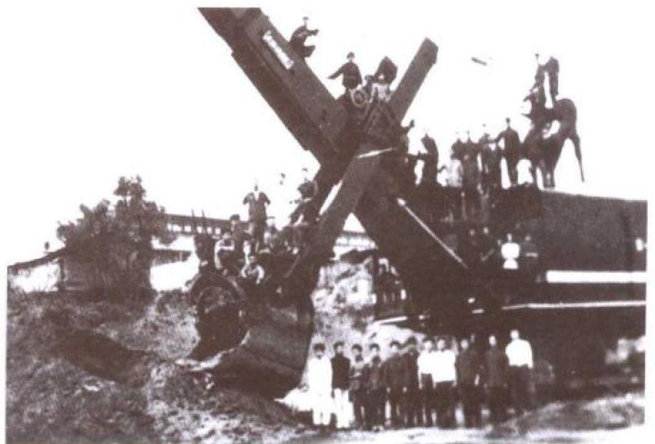
1961年，太原重型机器制造厂制造的我国首台4m³挖掘机
