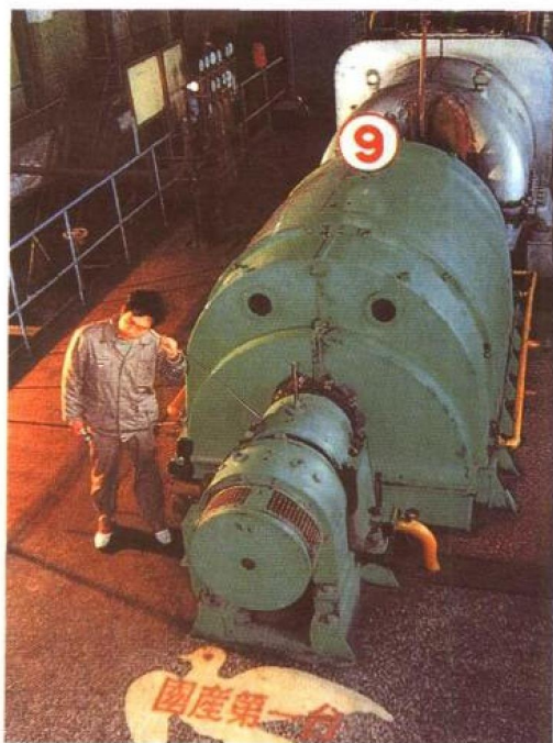
1955年，上海电机厂制造的国产第一台6000千瓦汽轮发电机组安装于淮南电厂
