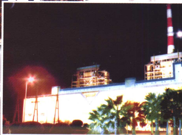
嵩屿电厂夜景
