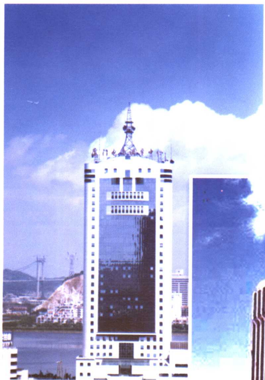
厦门电力调度中心
