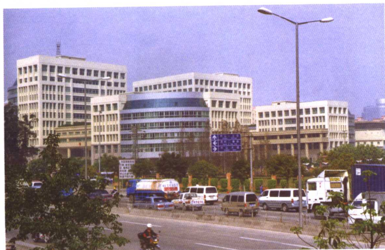
广州市天河区行政中心办公楼
