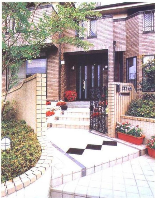
缓坡阶梯式的人内通道呈圆弧形铺设，给人一种端庄壮丽的感觉，和西式建筑的本宅相当搭配。地面全铺上磁砖，路宽2米，步行其中觉得气派、舒适无比。
