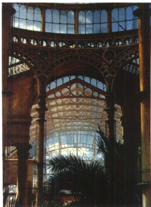
建築屋架以鏤空的圓形符號為裝飾，既簡潔美觀，又節省材料，這種構件的應用，給室內空間增加了宏大的氣氛。
