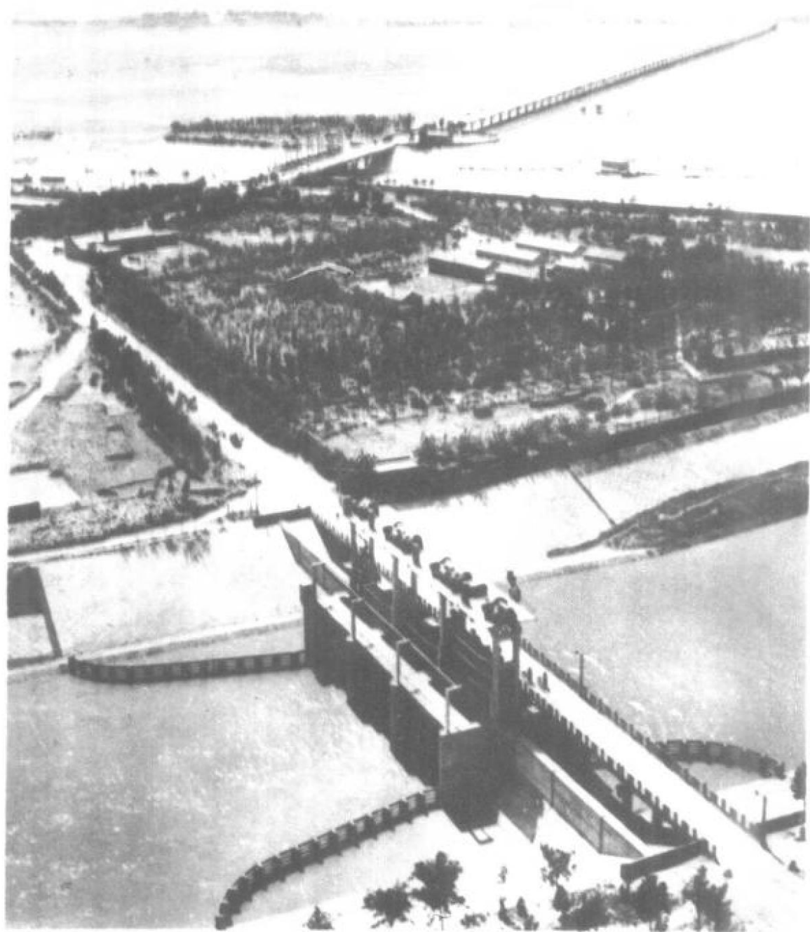
图为献县枢纽工程，包括子牙河节制闸，子牙新河丰槽的进洪闸，行洪滩地的进洪堰和公路桥。进洪闸行洪能力为一千一百三十秒立米，公路桥长一千多米。此枢纽工程能发挥行洪、灌溉、航运、为城市供水等多种效益。
