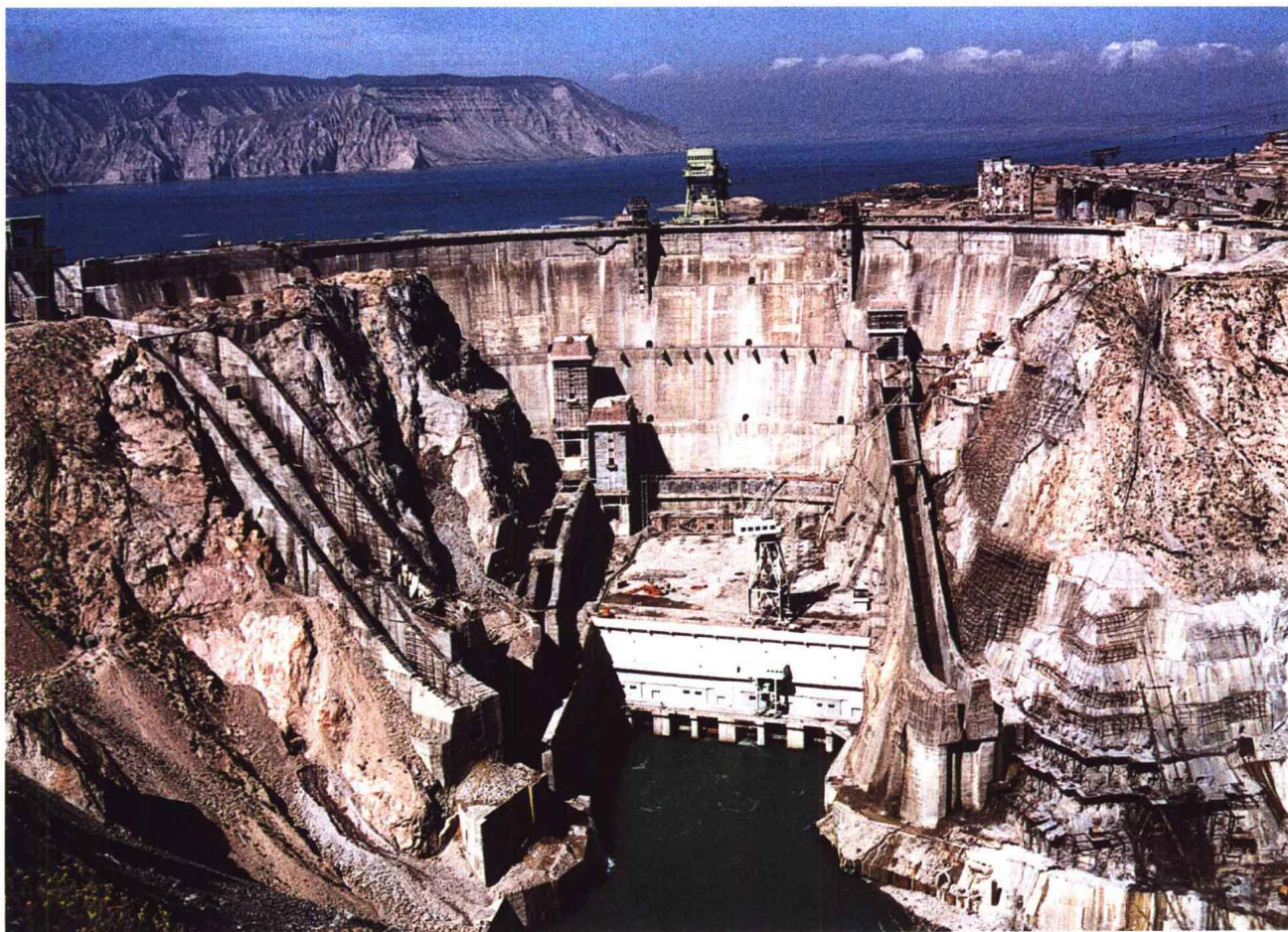
◆ 黄河龙羊峡水电站
