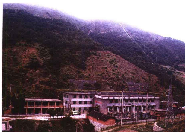
◆陕西沙沟河板凳堰水电站高压引水道和厂房
