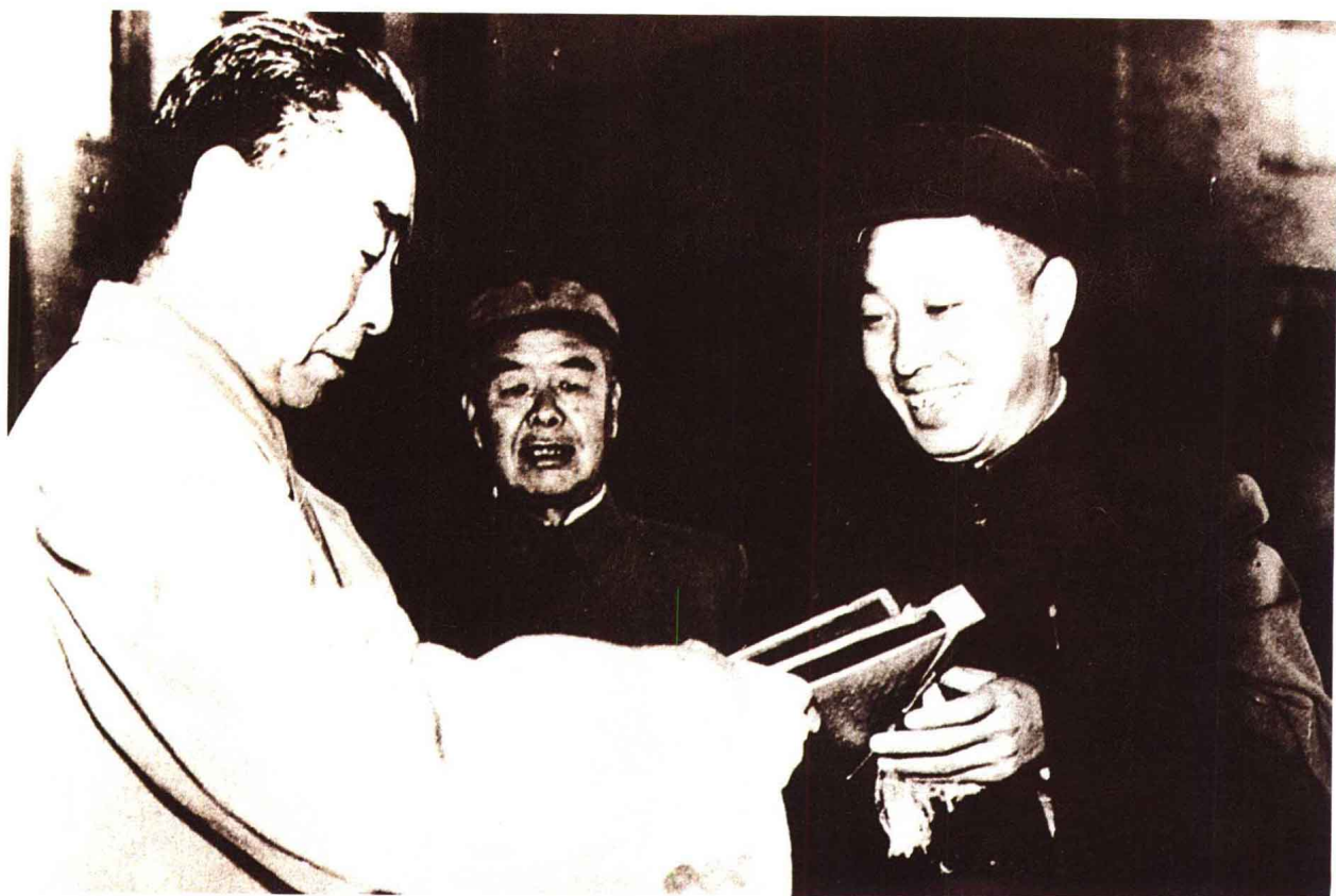
◆ 1959年11月，国务院总理周恩来在甘肃省省长邓宝珊（中）陪同下，听取刘家峡、盐锅峡水电站的建设情况汇报（图为中共刘家峡水电工程局第一书记杨一木向总理赠送工程建设画册）
