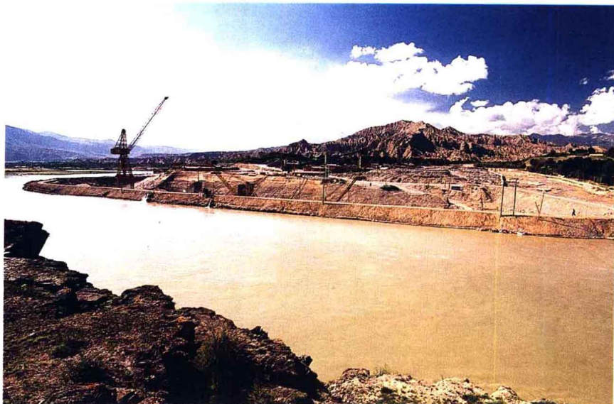
◆黄河尼那水电站开工准备工作
