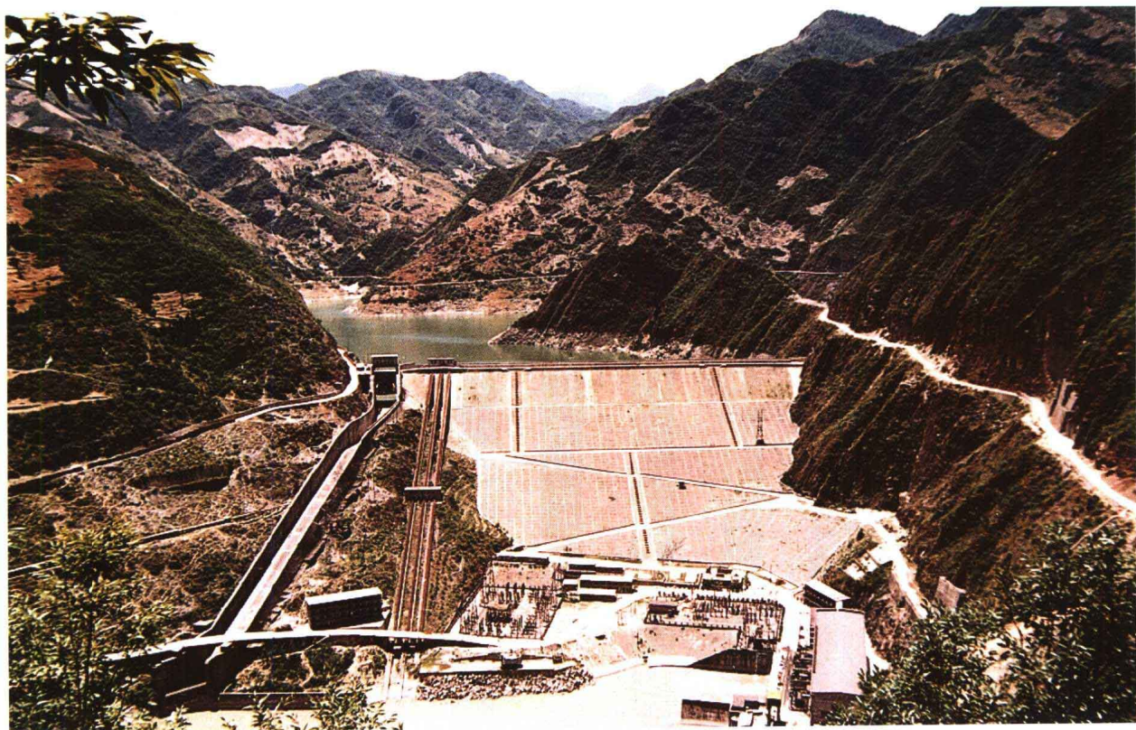
◆白龙江碧口水电站
