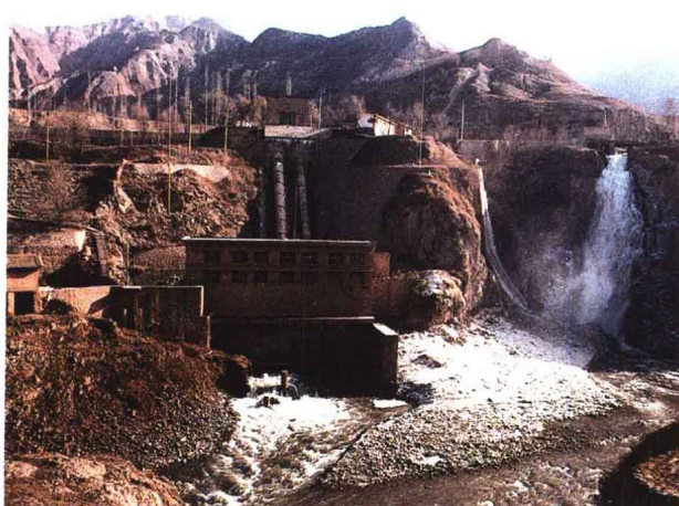
◆甘肃大夏河泄湖峡水电站
