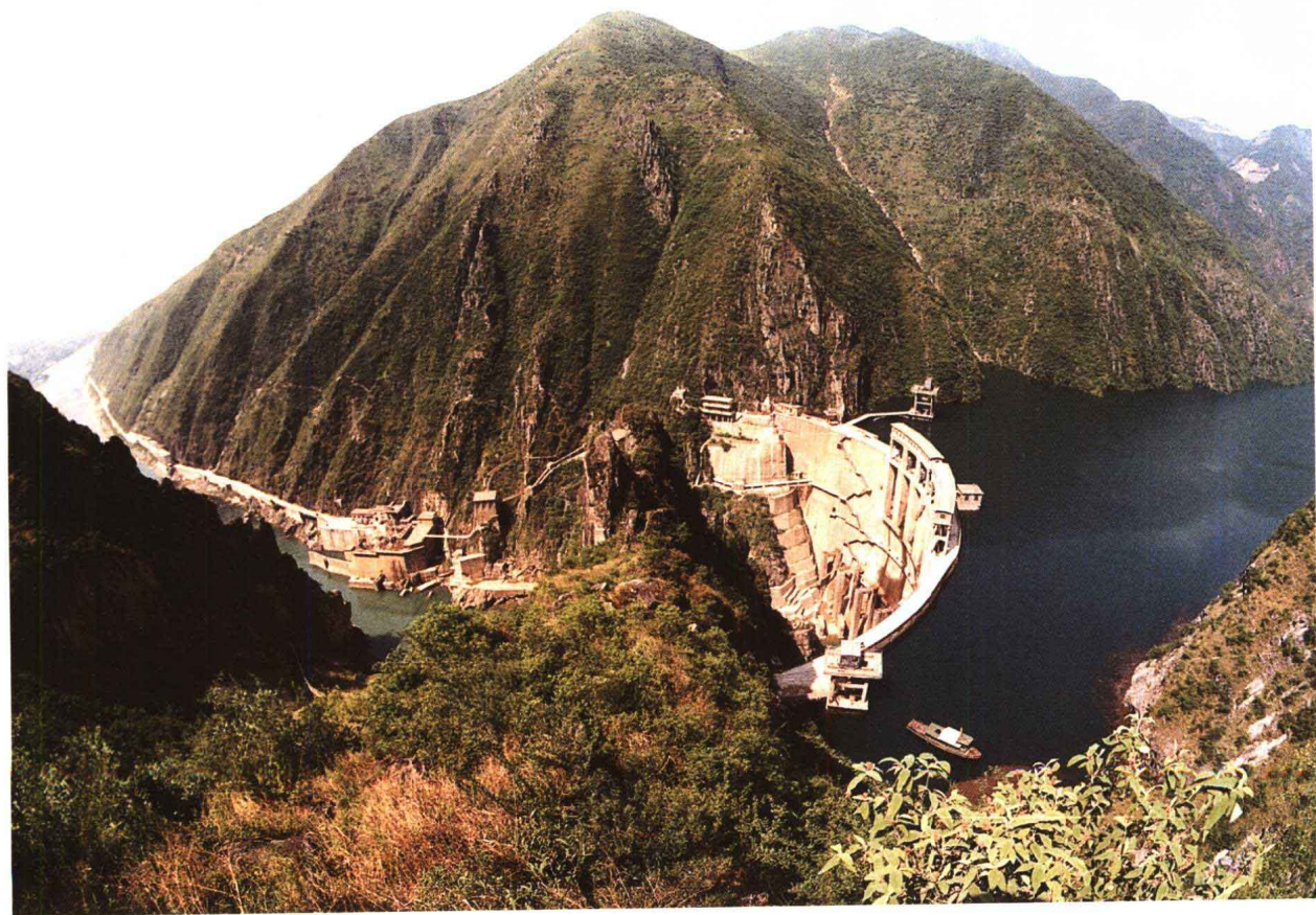
◆陕西褒河石门水电站
