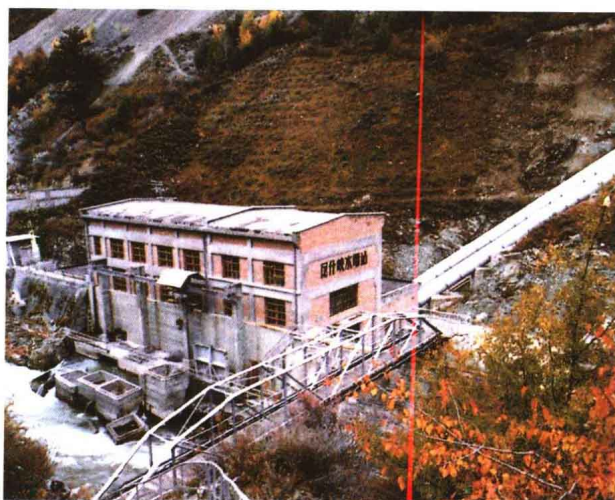
◆ 甘肃白龙江尼什峡水电站厂房
