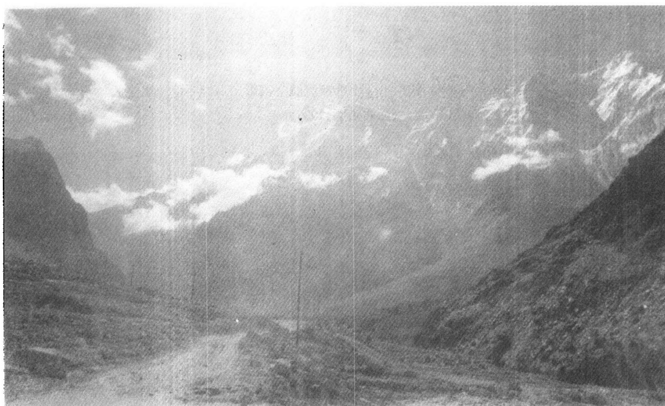
图 1-2-5 昆仑山区泥石流覆盖后的公路
