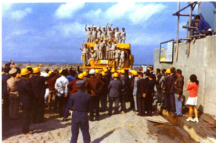
民國62年10月31日，工程人員在北堤拋石， 慶賀台中港第一期工程正式開工
