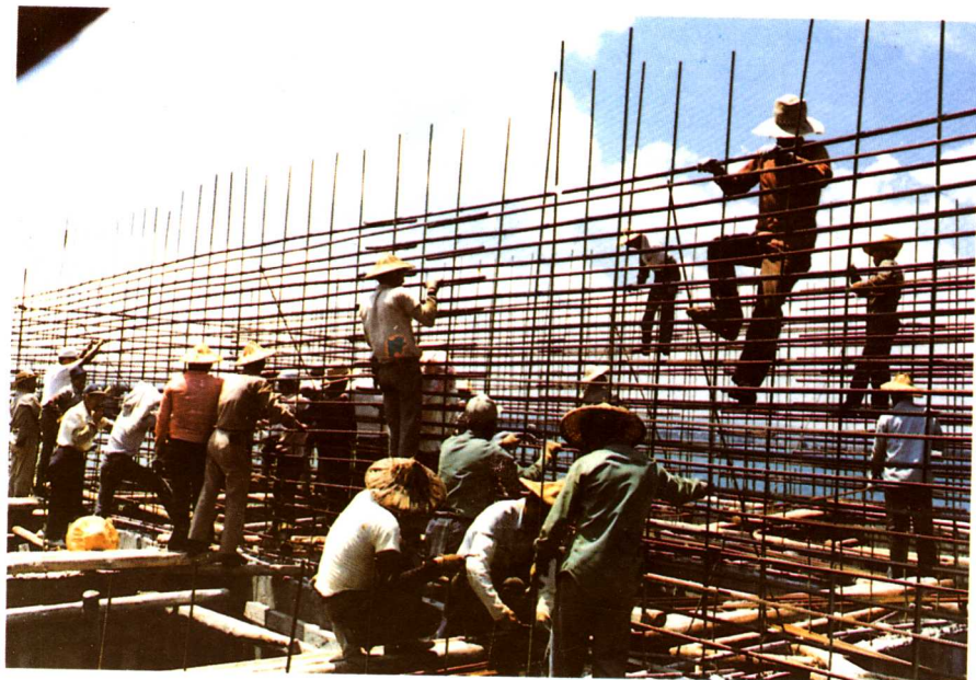
工人們繫沉箱鋼筋
