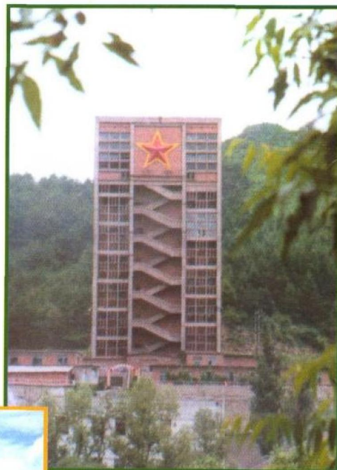
该矿主坑口雄伟壮观的提升井塔，日提矿能力2000余吨。
