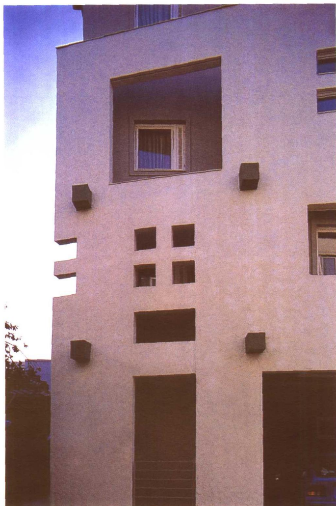
全面装饰墙壁角
