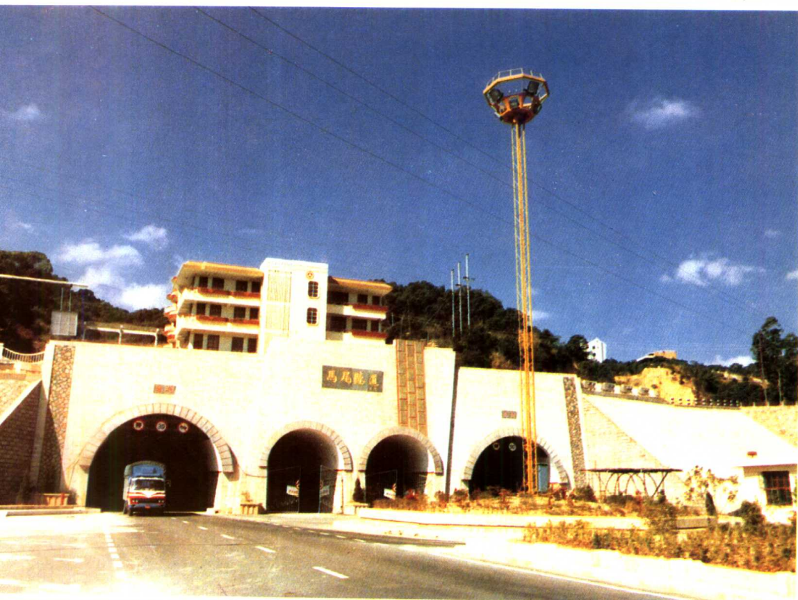
马尾隧道——单洞总长 1934.96 米，其中南洞 968.57 米，北洞 966.39 米。 (杨婀娜 摄)
