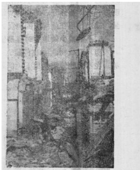
图 1-2 街巷过窄，地震后由于房屋倒塌将通道堵塞，影响人员疏散
