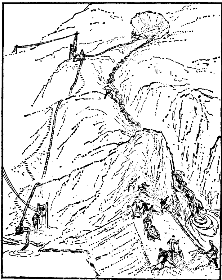
图 2 水枪冲土造泥示意图
