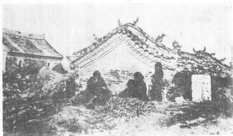
黄河泛滥时被泥沙淤没的房屋
