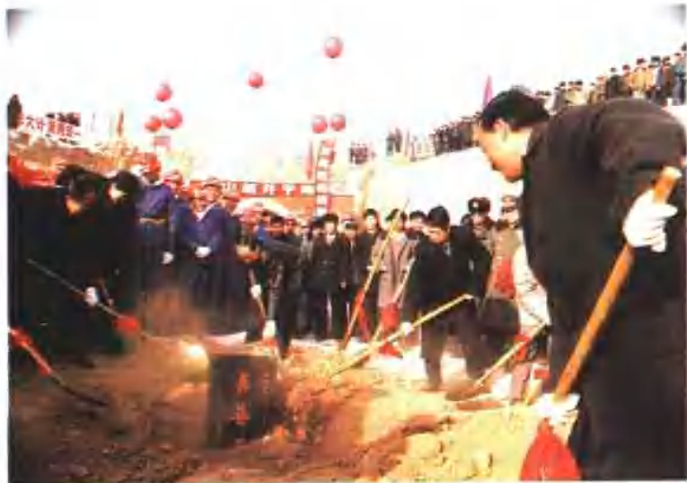
1991 年象山新井开工
