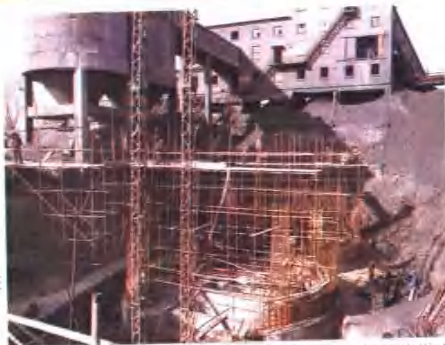
80年代末,建筑公司施工大型圆筒煤仓
