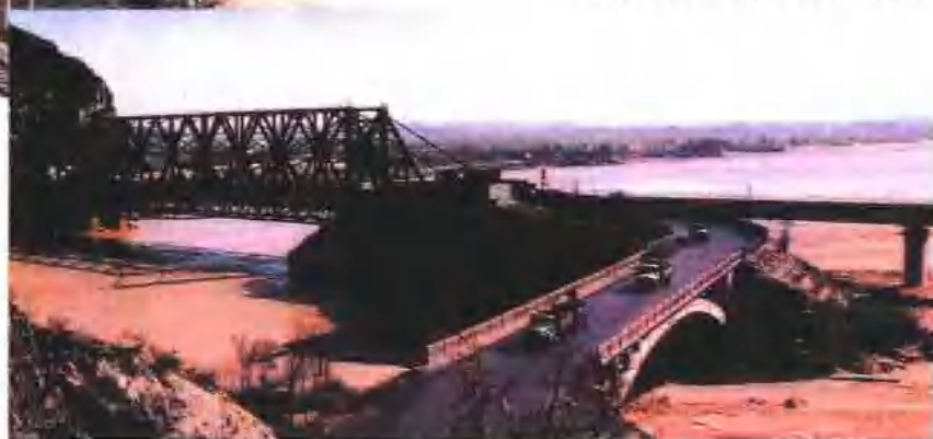
禹门口黄河铁路、公路大桥
