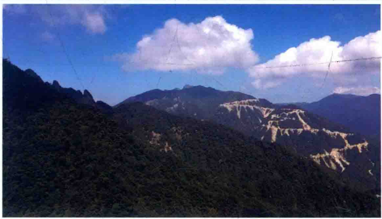
南岭之殇：违规修建的通往第一峰的公路
