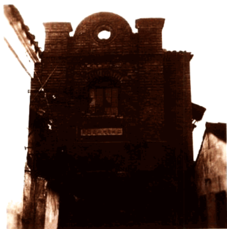
苏州道前街 2.3 千伏配电所
