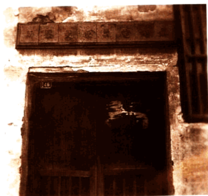
苏州悬桥巷 2.3 千伏配电所
