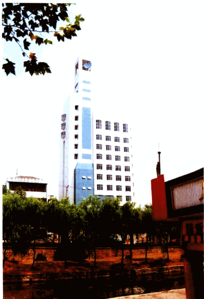
常熟市供电局生产调度大楼(1994 年建)
