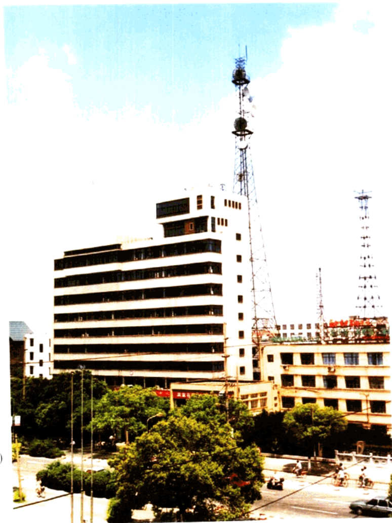
苏州供电局生产调度大楼(1985 年建)
