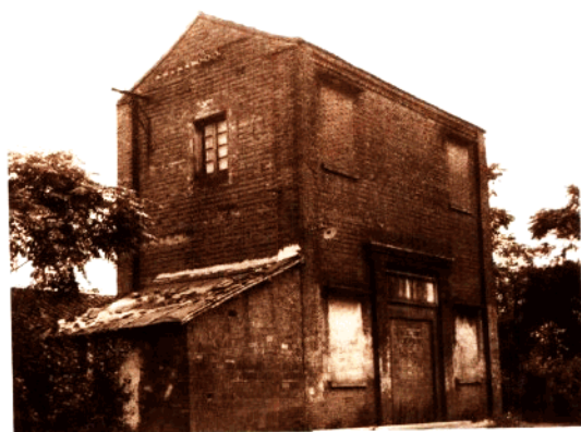
16.5 千伏吴江盛泽变压所
