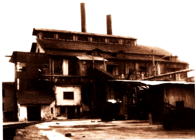
苏州电气公司发电厂厂房
