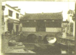
安徽唐楼过街廊桥
