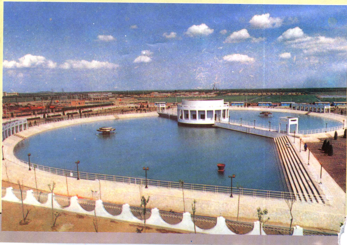
▽ 为确保厂内供水不断，在厂区内设有容积为 4100\text{m}^3 的原水贮水池。
