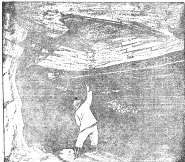
第2圖 經過四年後由槽鐵支撐的頂板情況
