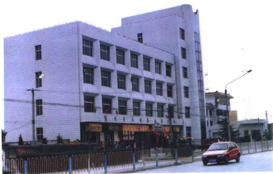
▲ 1994 年 10 月，霸州市土地管理局建办公楼，投资 200 万元，建筑面积 2300 平方米
