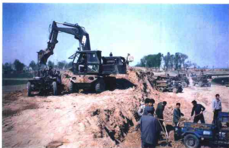
◀ 1996年，霸州市煎茶铺 镇花桑木村平整废堤造地 200亩
