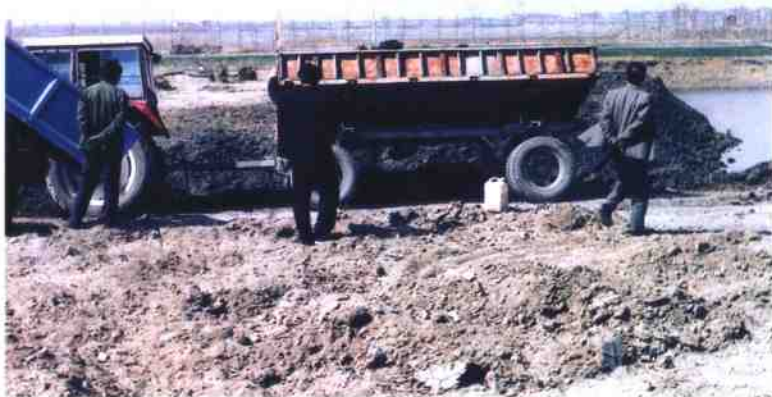
► 1995年，霸州市信安镇 陈家堡村填坑造地，图是造 地现场
