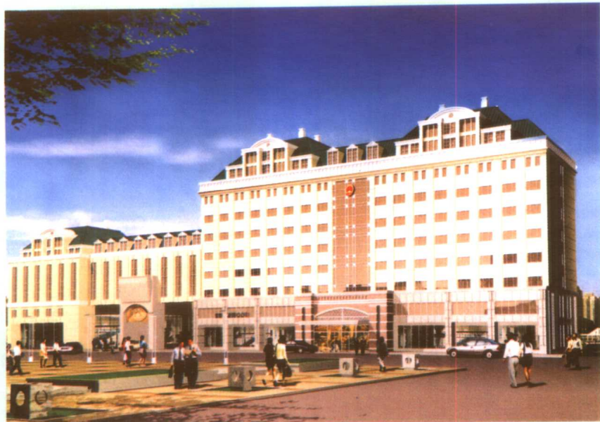
县政府办公大楼
