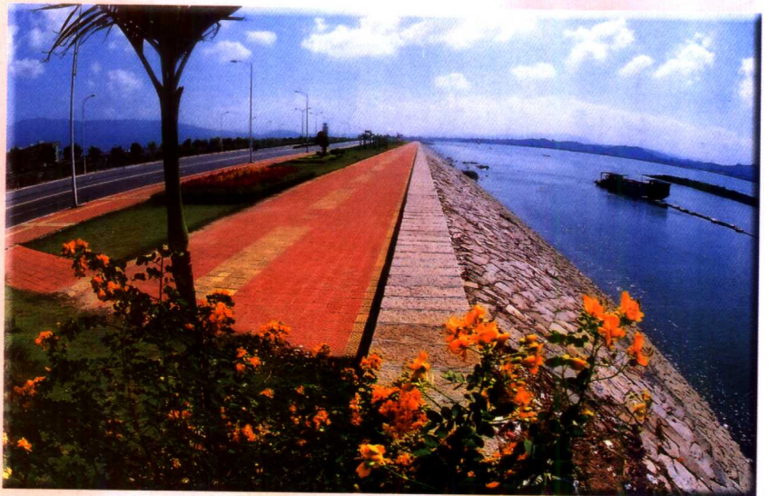
福建省千公里江堤建设规划长 1014 公里,至 2001 年底全省超额完成省政府下达的堤防建设任务,使福建省成为全国第一个所有县以上城区设防基本达到国家规定标准的省份。图为路堤结合的闽江下游北港北岸防洪堤。 (省水利厅供稿)
