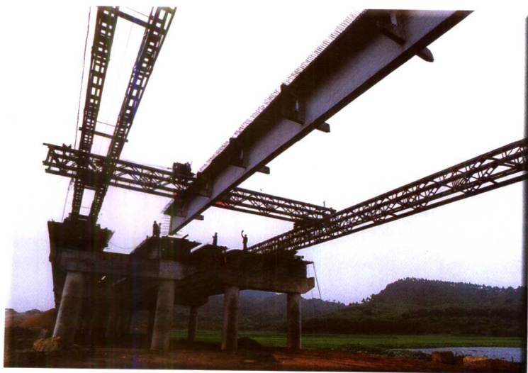
漳州至诏安的高速公路主线全长140.5公里,路基宽26米,双向四车道,计划于2002年底建成通车。图为诏安港口特大桥进行T梁吊装。（沈学溪 摄）
