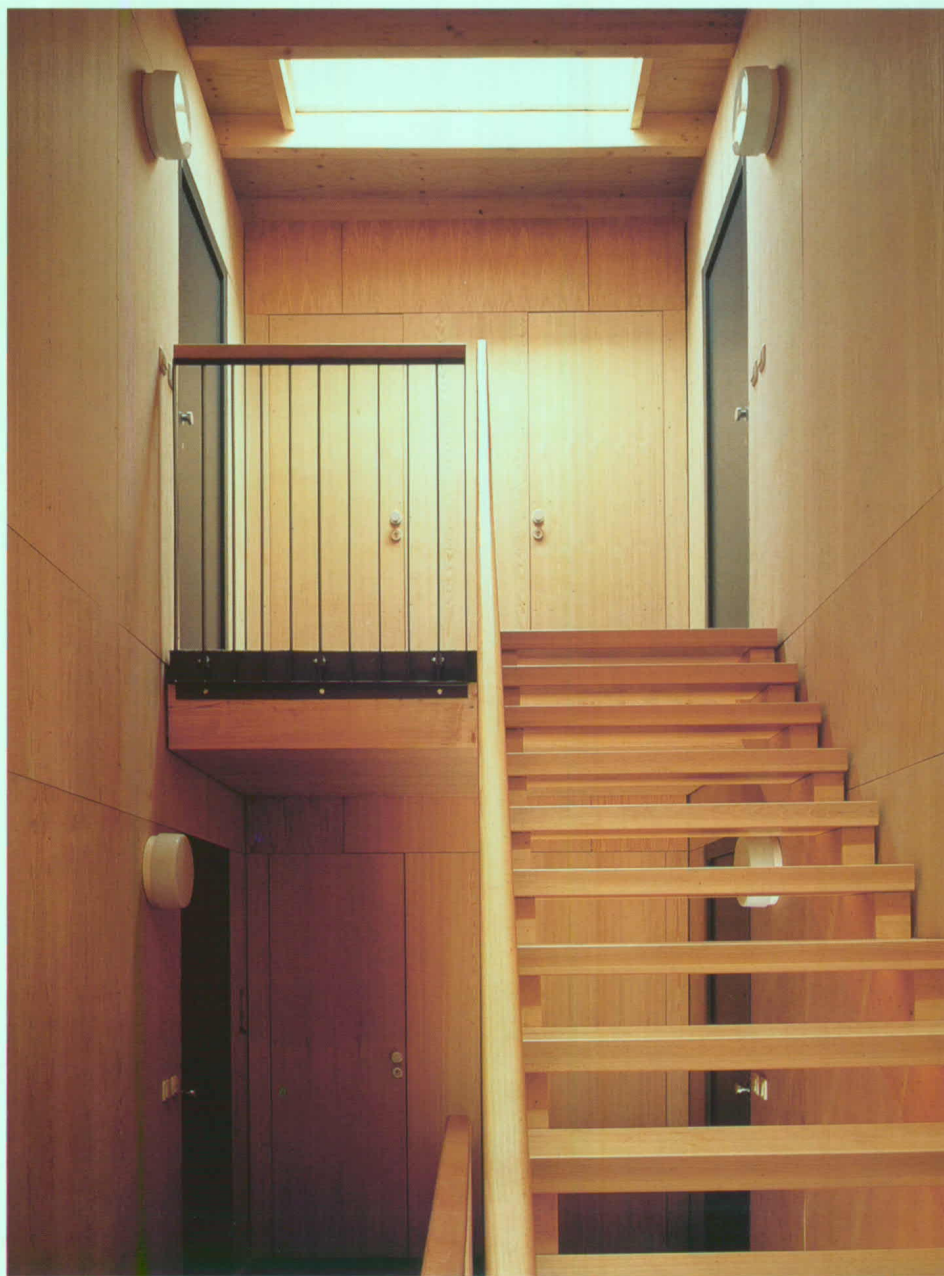
为了隐蔽开敞式的楼梯井, 用木板条把开口盖住。它能让光线渗入室内。
