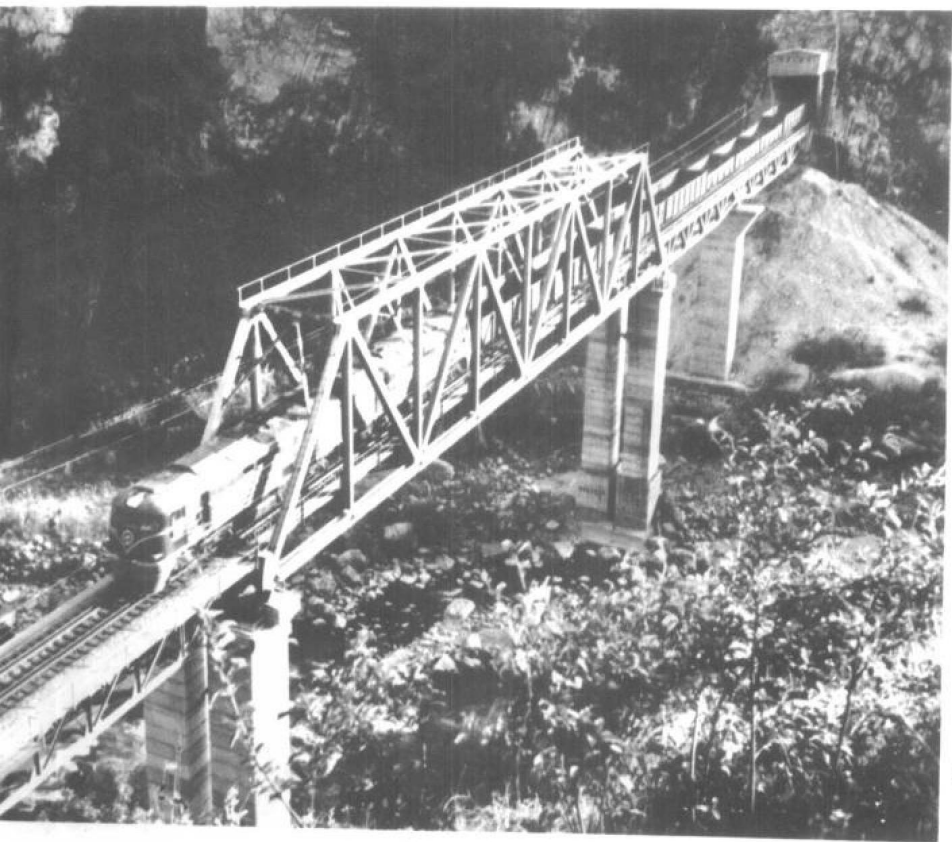
成昆铁路上，万水千山，桥隧相连。全线隧道和桥梁总长四百多公里。这是火车通过拼装式桥墩的牛日河四号桥。
