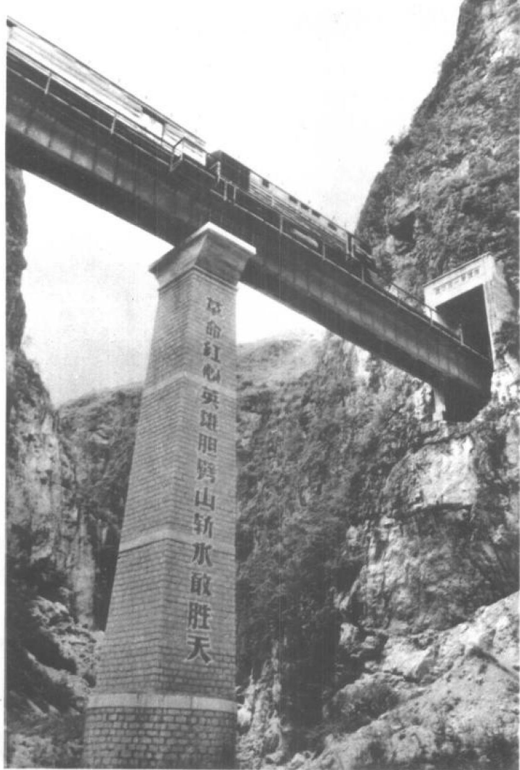
成昆铁路工程艰巨，桥隧相连，修建十分困难。类似这样桥入隧道，洞中有桥的工程还有多处。
