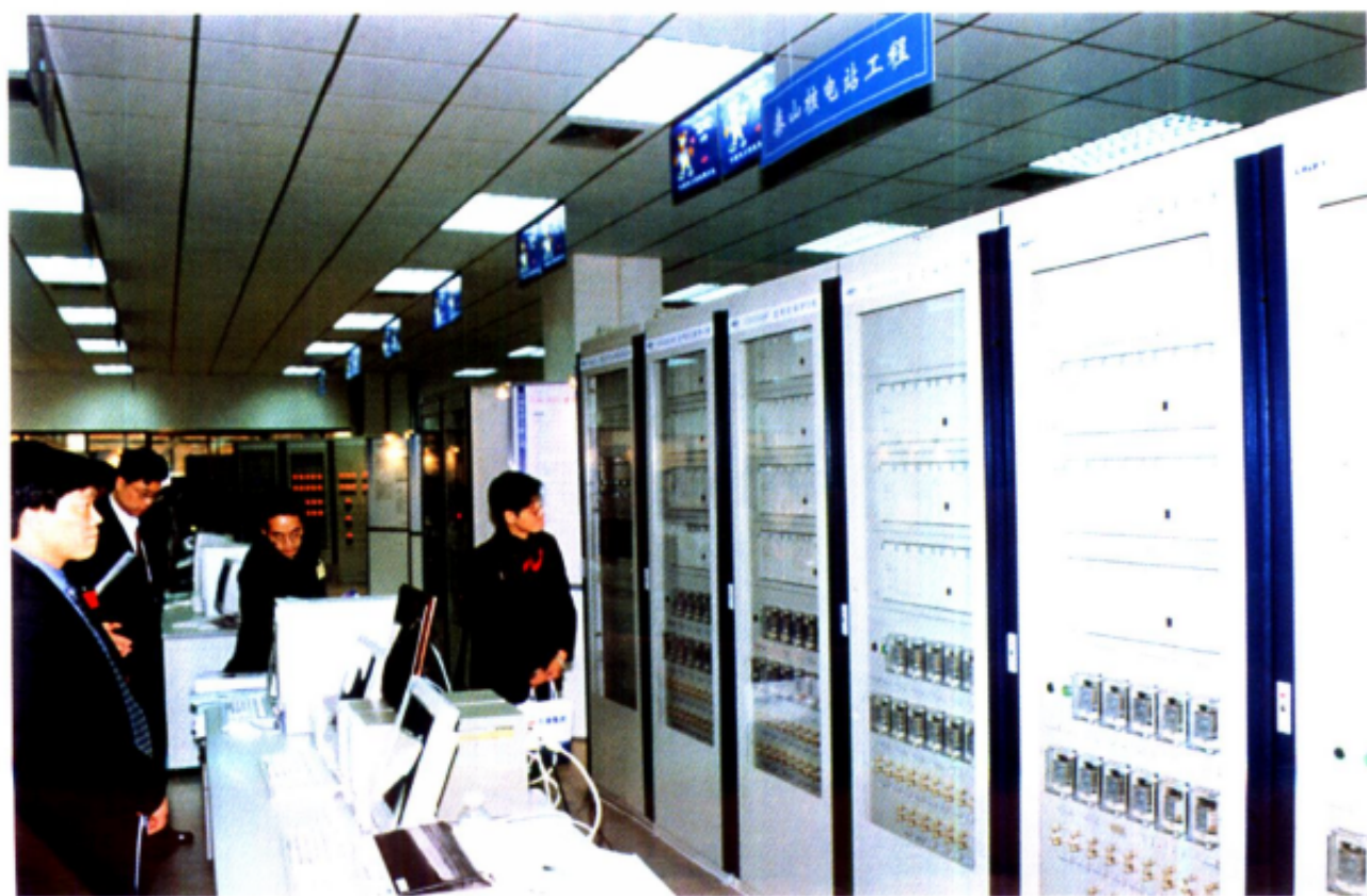
▲ 图为许继集团有限公司为泰山核电站生产的成套保护及自动化产品。
