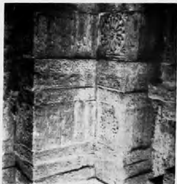
图二 墓室侧壁转角构筑情况
