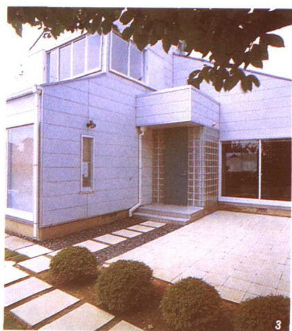
1. 南侧外观。单坡屋顶，由于高度和方向的多种变化形成的造型
