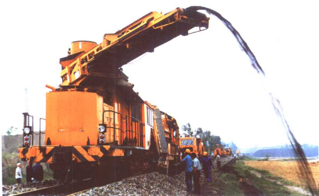
引进铁道线路大型养路机械，给养路工作插上了科技的“翅膀”，为列车提速奠定了良好基础。图为北京铁路局大型清筛机正在进行首床清筛作业
