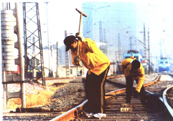
为提高线路质量，确保运输安全，工务系统职工加强设备的维修和养护，对重点区段线路坚持双人巡检制度。图为北京西工务段职工对重点区段进行检修
