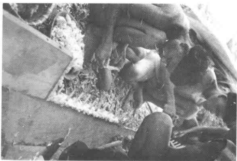
第2圖 船板の接目に根船の充填 (著者撮影)
