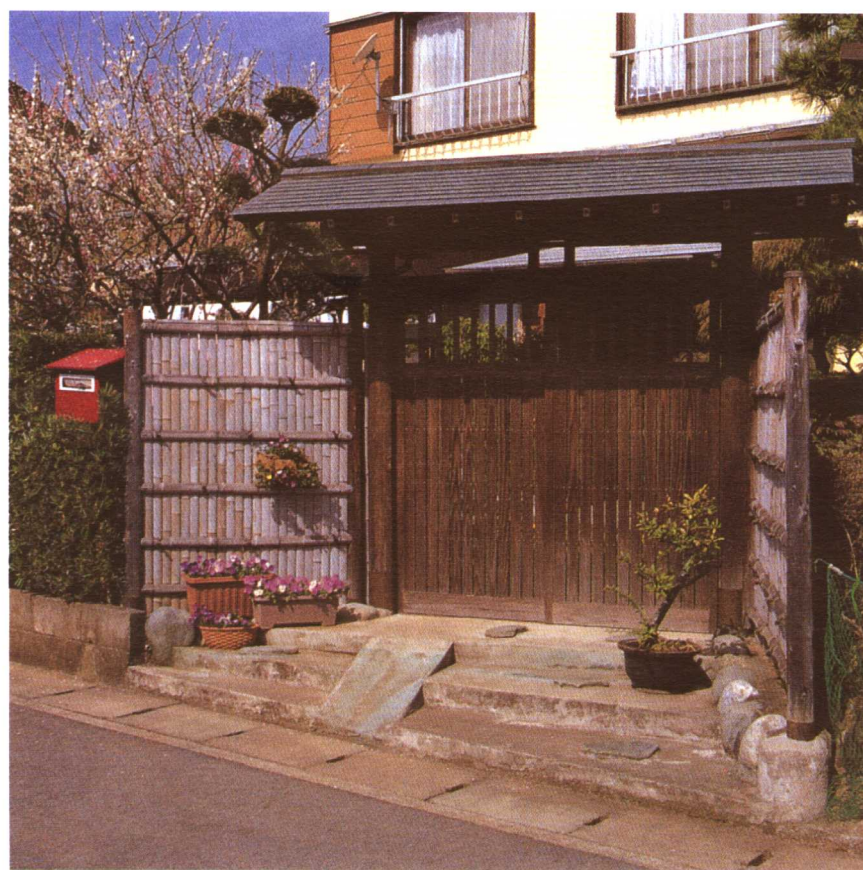
铺铜板的人字门的两侧是建仁寺围墙。
