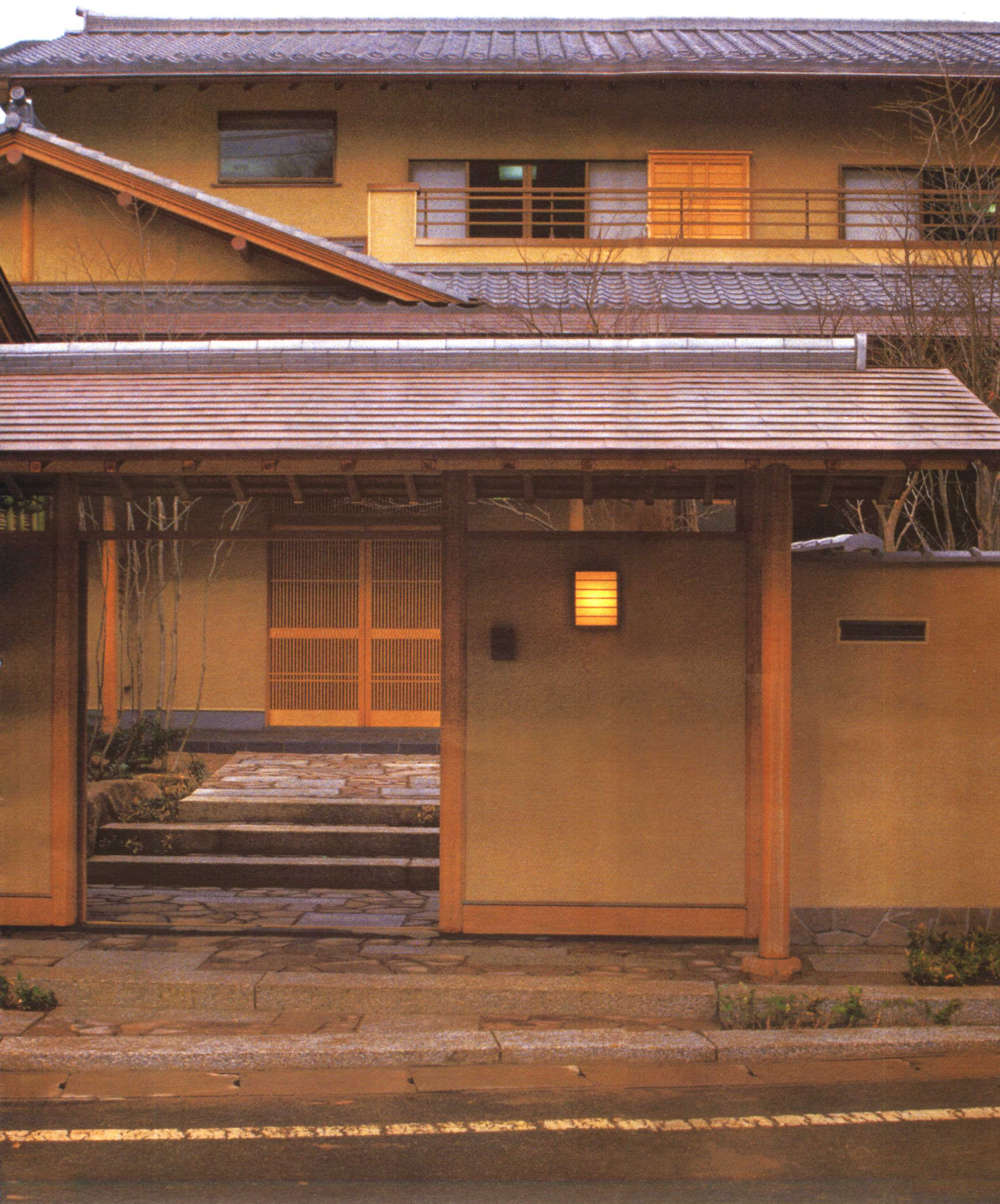
铺铜板的人字茶室门。栋梁铺瓦，便门前是装有粗格窗翼墙。
