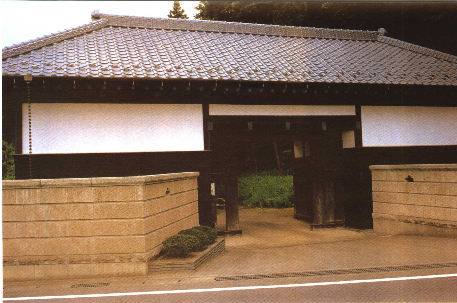
铺四面坡瓦的长屋门。
