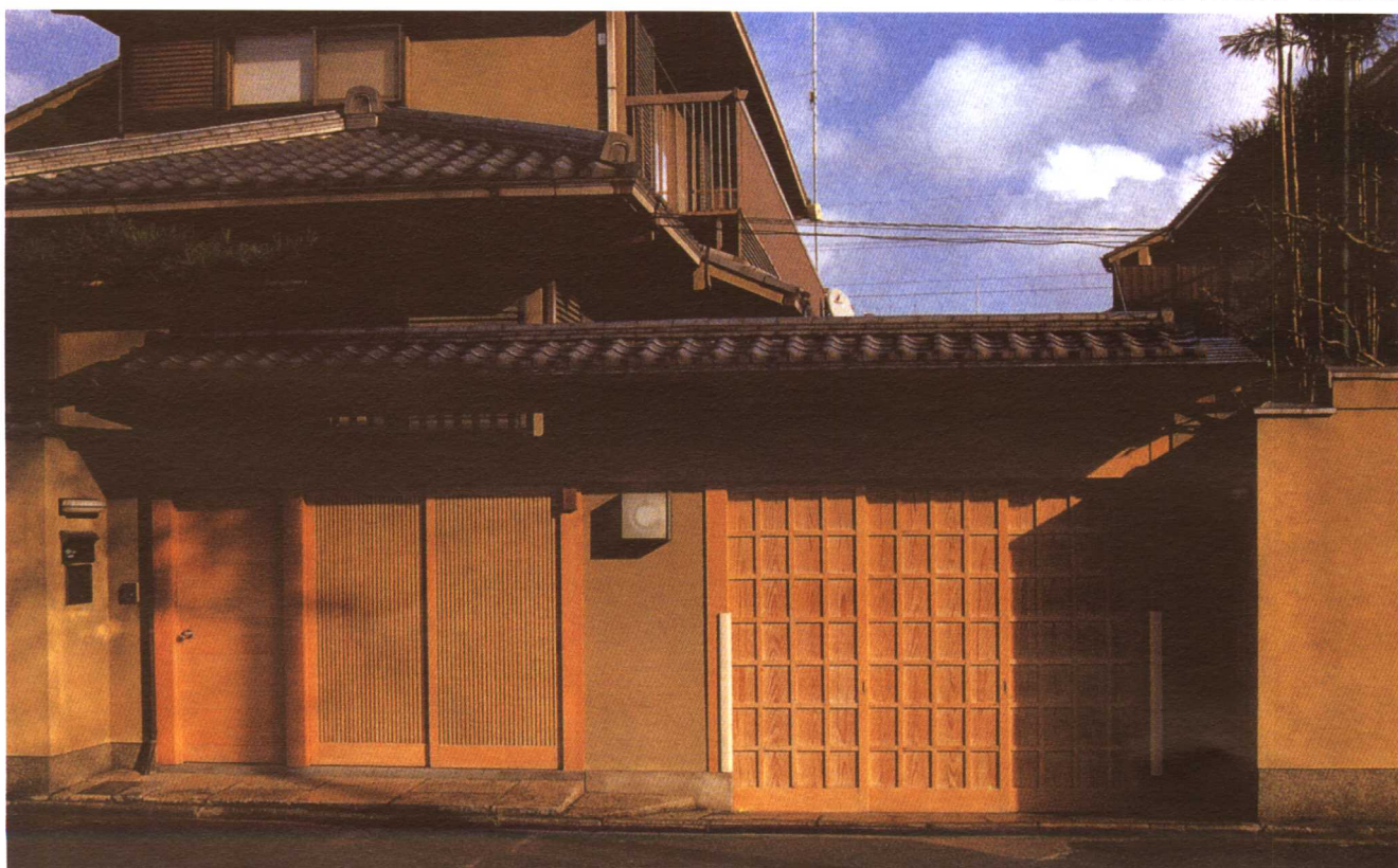
使用木拉门作车库的门，非常协调。
