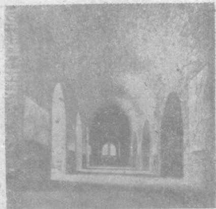
图 1-7. 南京灵谷寺无梁殿
