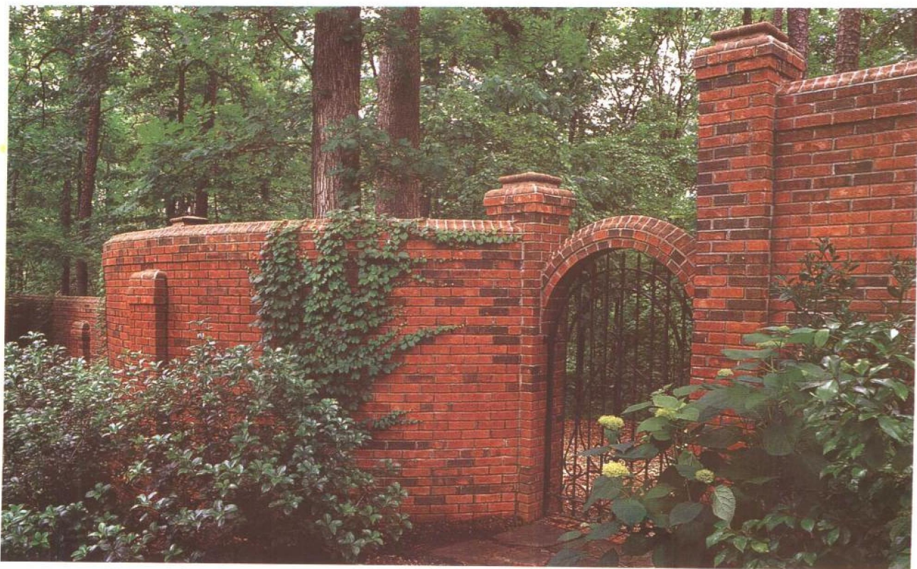
这座砖墙封闭了它所包围的院落，是入侵者较难跨越的障碍
