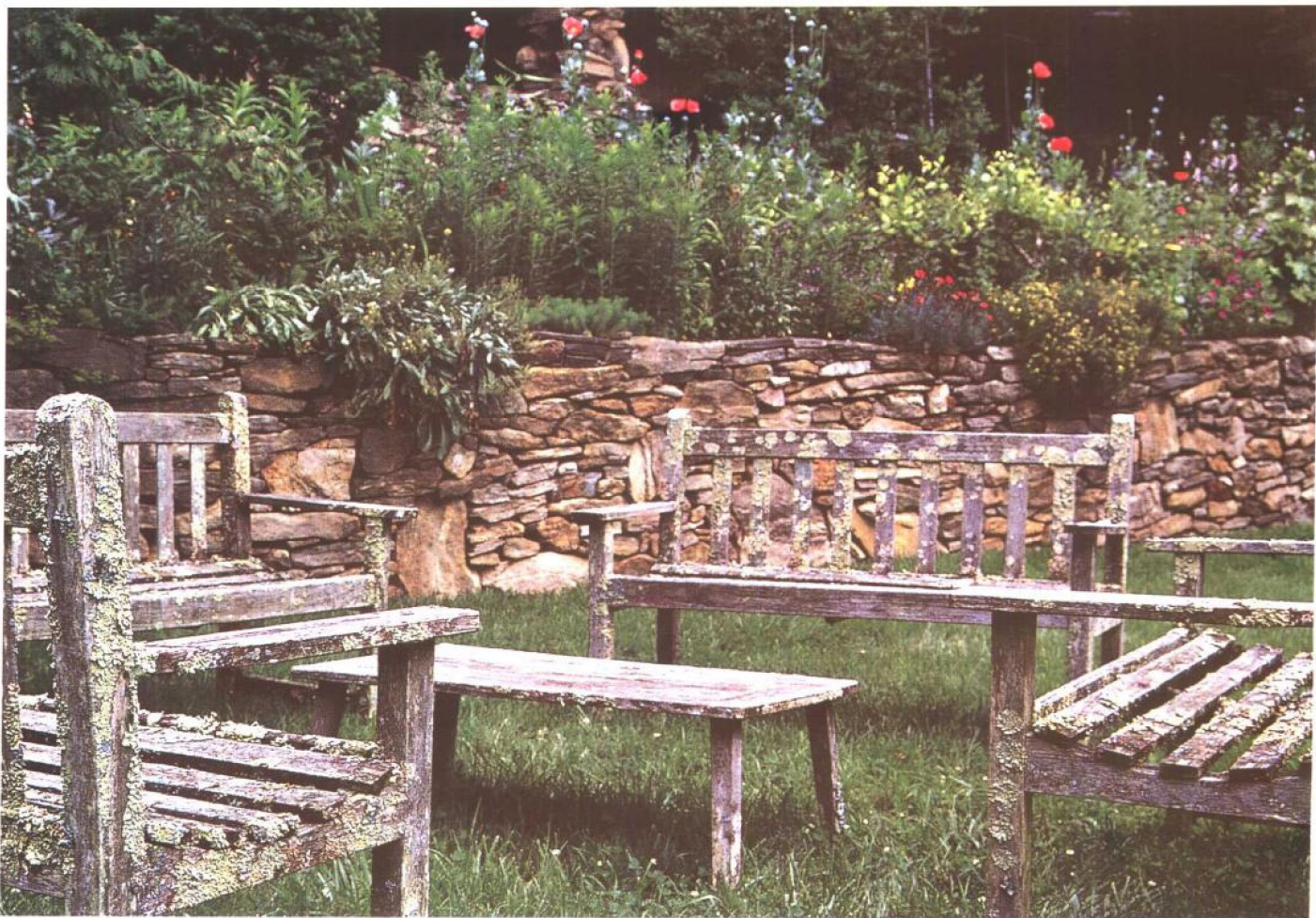
可以通过建造石头挡土墙，把院子里的一个斜坡变成有用的场地
