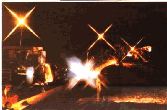
夜以继日抢任务 1999年2月26日按时完成全线主体焊接，创造出管道建设史上十大记录
