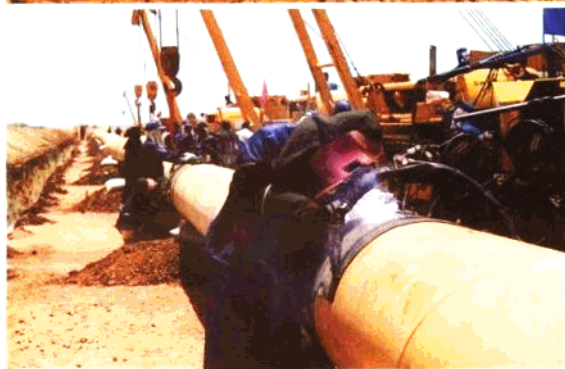
管道焊接 全线在10个月内焊接126425道焊口，X射线检测一次合格率93.85%
