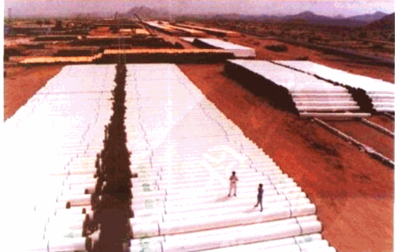
钢管集散地 为保证施工供管，在辛卡特建立了钢管集散地
