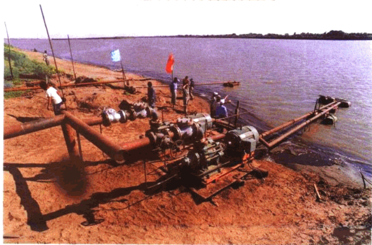
在尼罗河取水试压 旱季水源干涸，尼罗河成了唯一试压用水水源
