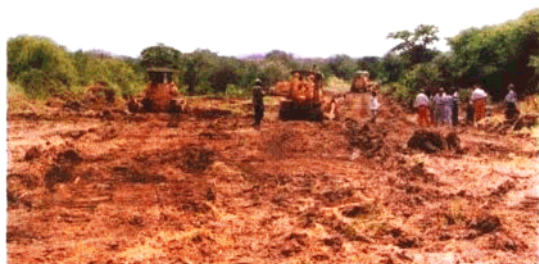
热带雨林扫线 全线240公里热带雨 林地段，施工极其艰 难
