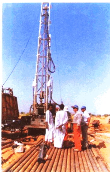
打井取水试压 全线共打井 57 眼， 以弥补试压水源严 重不足
