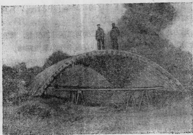
图 2. 芦苇束拱圈构造
